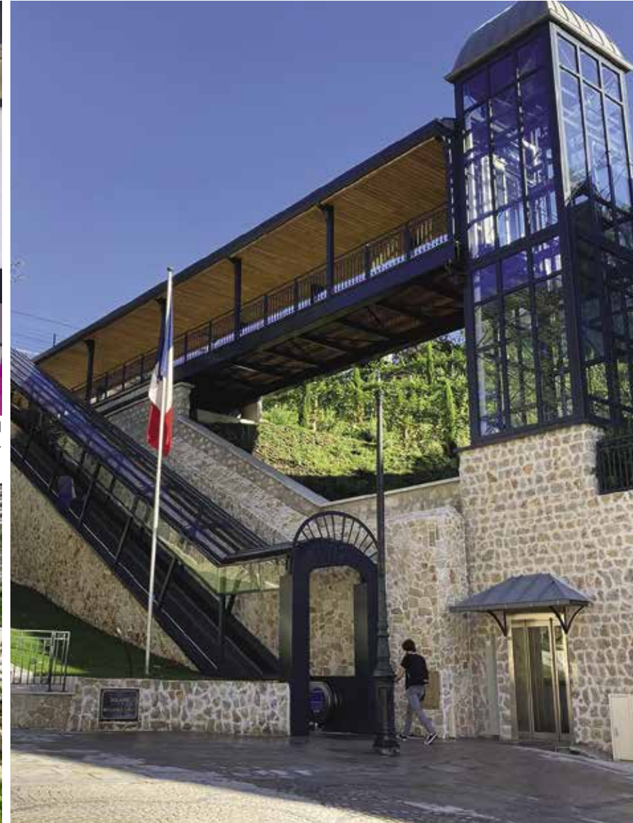
L'escalator et l'ascenseur de la gare
